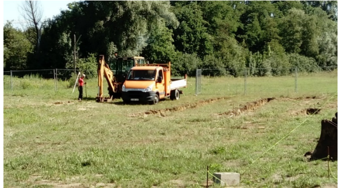
De eerste spadesteek aan de nieuwe club: het graven van de sleuven voor de fundering.
